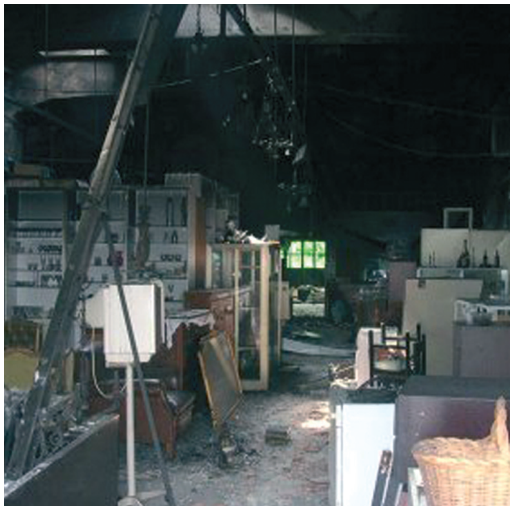
La sede dell'associazione Amici di Piazza Grande dopo l'incendio del settembre 2004
